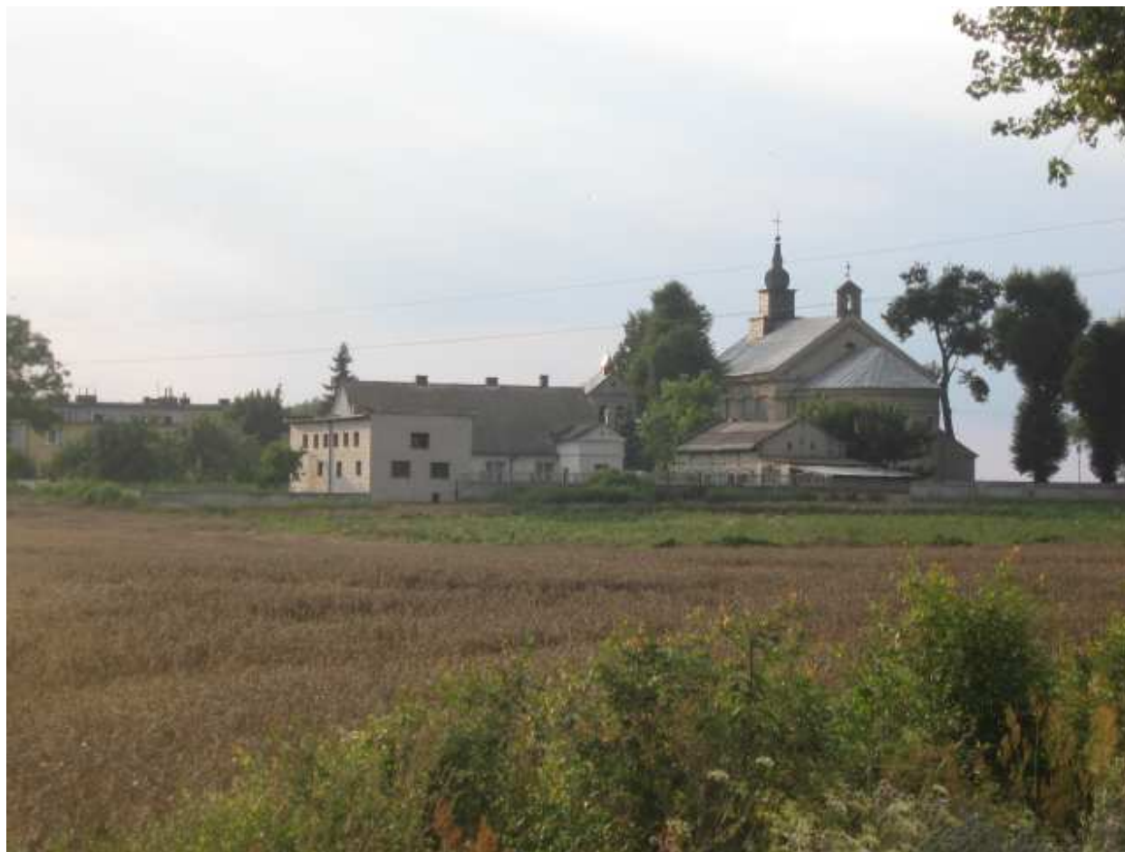
Widok na Broniewo od strony północno-zachodniej
