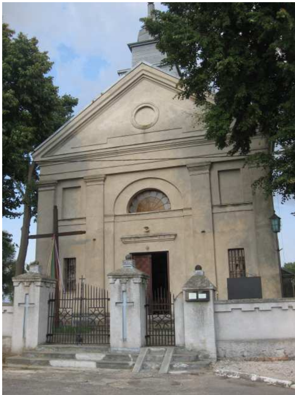
Wejście do kościoła od frontu
